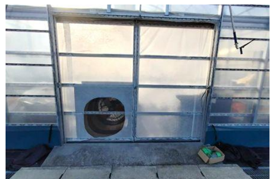
図-10 3面閉鎖の開放面 網戸の部分に花粉フィルターを貼り、 扇風機で排気している。
