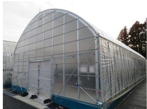
図-9 完全閉鎖をしたハウス
