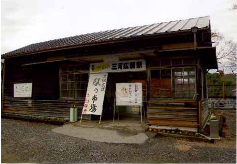
名鉄三河線旧三河広瀬駅駅舎
