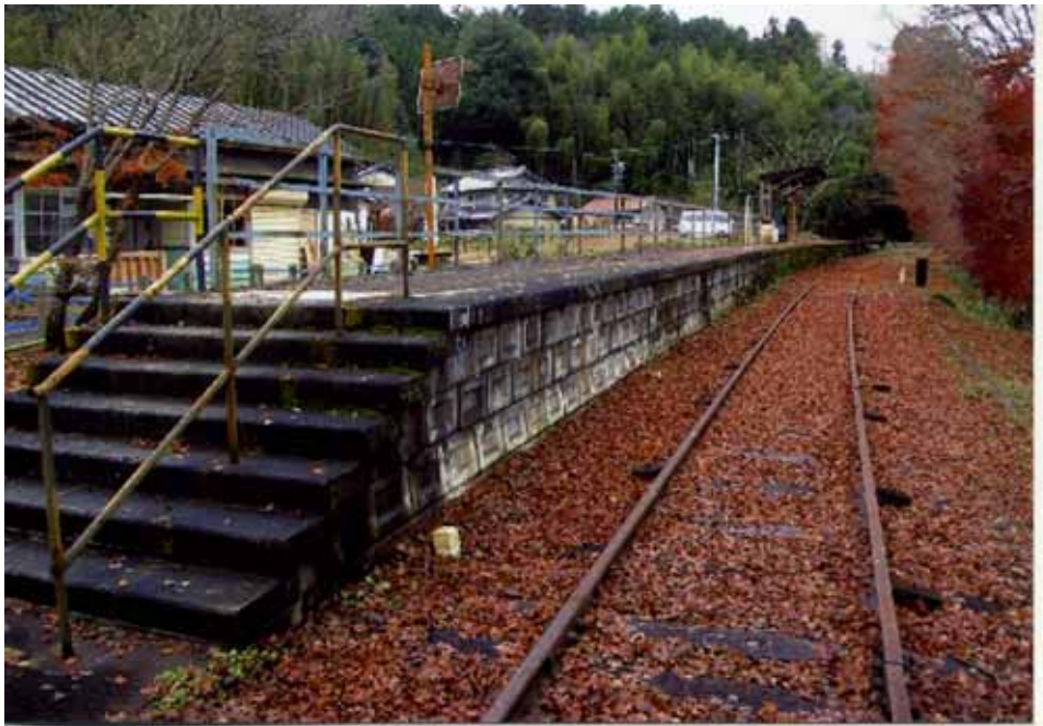
名鉄三河線旧三河広瀬駅プラットフォーム
