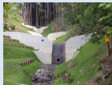
治山施設の整備
