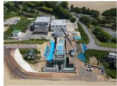
農業用排水機場
