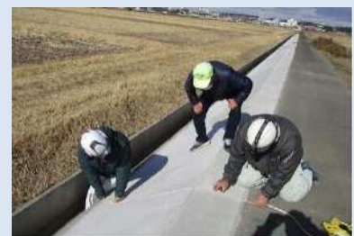
水路法面の補修
