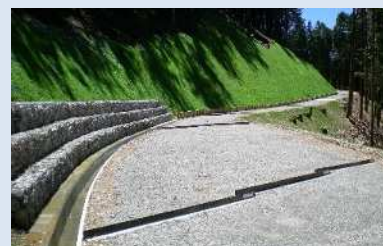
過疎山村地域における 基幹林道の整備
