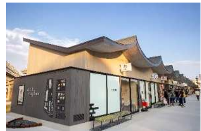
木造商業施設
