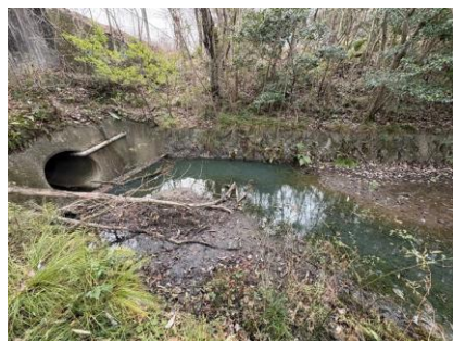
放流池、排水暗渠管（左）（残置）
