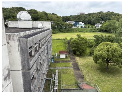
グラウンド（奥）、実験実習棟（左）
