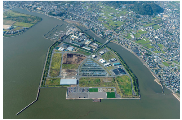
御津1区 航空写真(2025年9月撮影)
