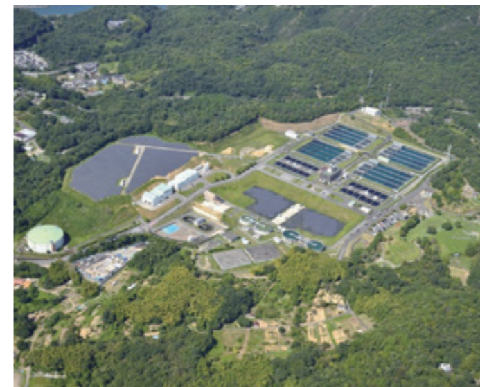
犬山浄水場 (2020年9月撮影)
