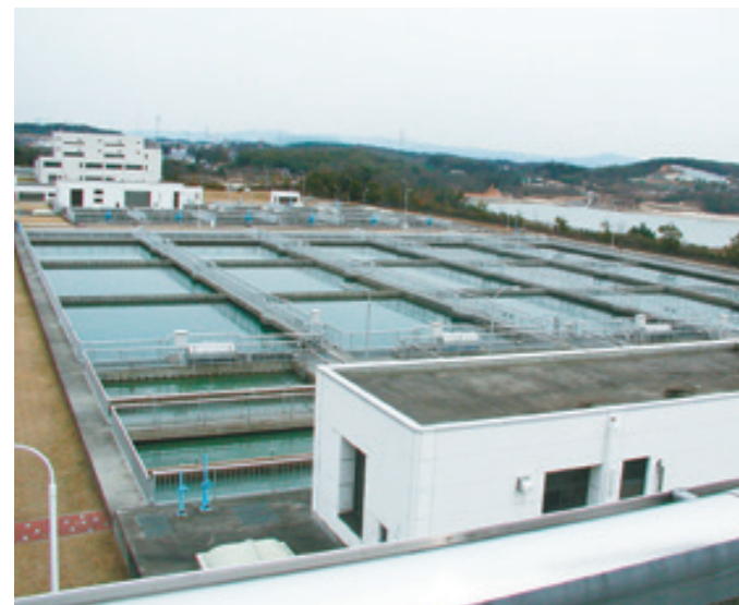
尾張東部浄水場
