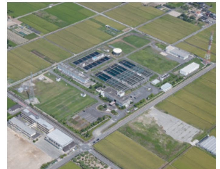
尾張西部浄水場 (2018年8月撮影)
