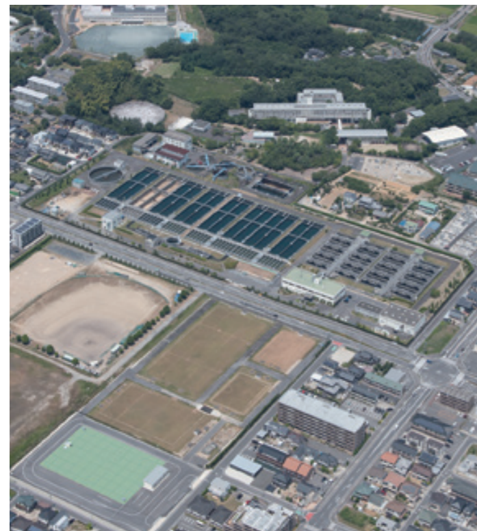
豊田浄水場（2018年8月撮影）
