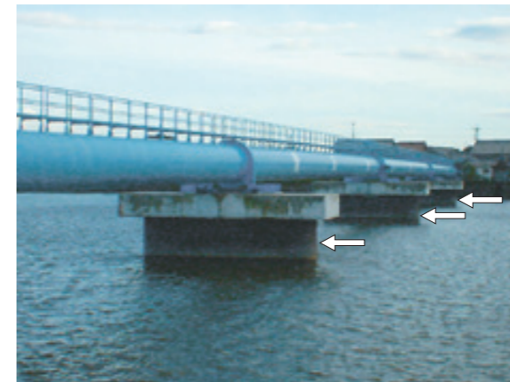
下部工耐震補強の事例（筏川第2水管橋）
