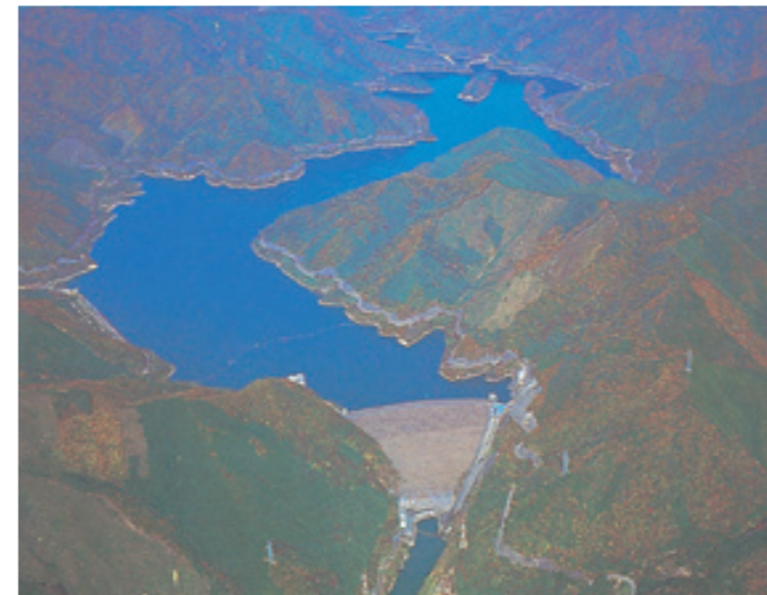
岩屋ダム（1996年11月撮影）
