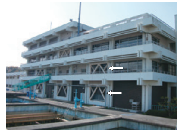
建物の耐震化事例（豊橋浄水場）
