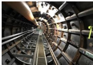
管路更新（シールド工事）
