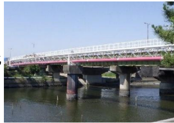
水管橋の耐震補強
