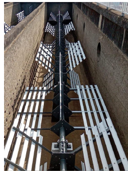
沈澱池機械更新
