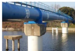
水管橋の耐震補強
