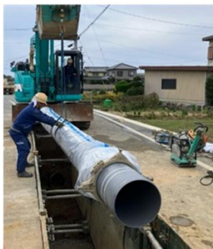
管路更新（耐震管への布設替え状況）
