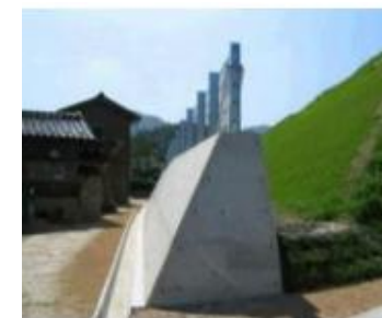
土砂流入防止壁のイメージ ※出典：防災・減災、国土強靱化のための5か年加速化対策（内閣官房ホームページ）加工
