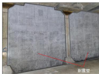
浄水場の耐震補強
