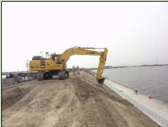
ICT建設機械による法面整形 (日光川)
