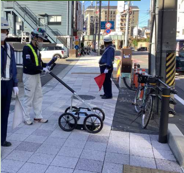
地中レーダー探査の様子
