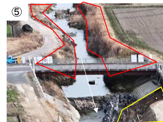
⑤ 逢妻男川：護岸工実施予定 (通学橋上流)
