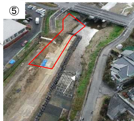
逢妻女川：護岸工実施状況 (松竹橋上流)
