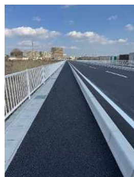
刈谷市 (透水性舗装整備)
