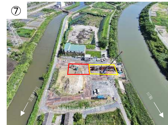
⑦ 五箇村川：本體工実施状況 (五箇村川中流排水機場)
