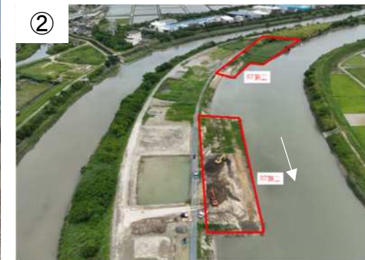
② 逢妻川：河道拡幅実施状況 (JR東海道本線付近)
