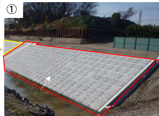
① 境川：護岸工実施状況 (石ヶ瀬川合流部付近)
