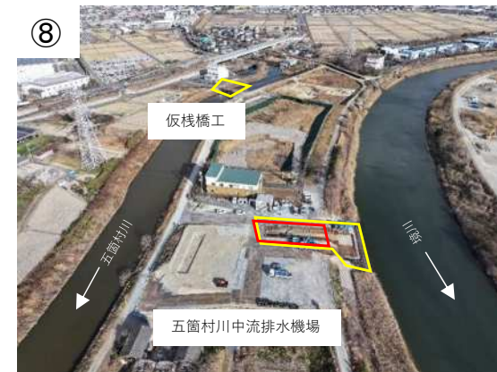
五箇村川：本體工実施状況 (五箇村川中流排水機場)
