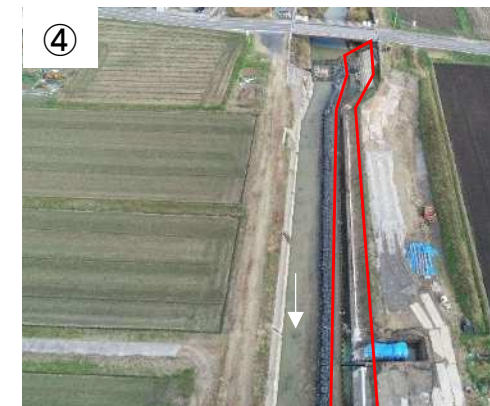
④ 逢妻男川：護岸工実施状況 (通学橋下流)
