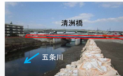
②五条川：橋梁改築
