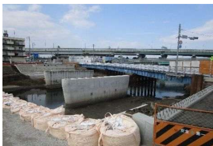
①.清洲橋の改築（五条川）（愛知県）
