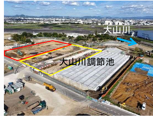
⑦大山川調節池：本体整備
