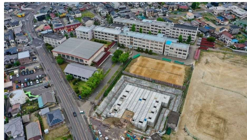
古知野高等学校地下貯留槽<江南市>
