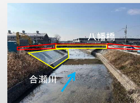
④合瀬川：橋梁改築、河道整備
