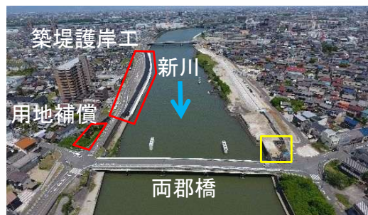
①新川：橋梁改築、築堤護岸工、用地補償
