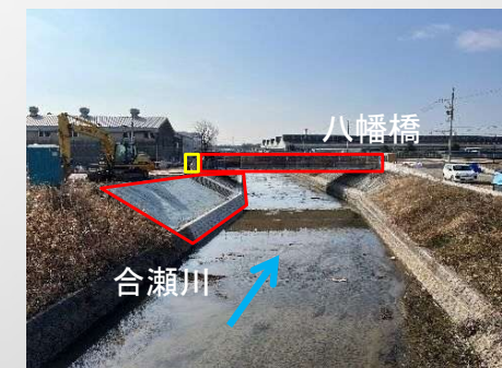
④合瀬川：橋梁改築、河道整備
