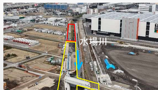
③水場川：河道整備
