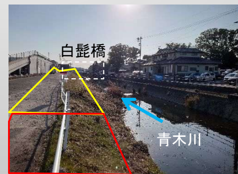
⑤青木川：河道整備
