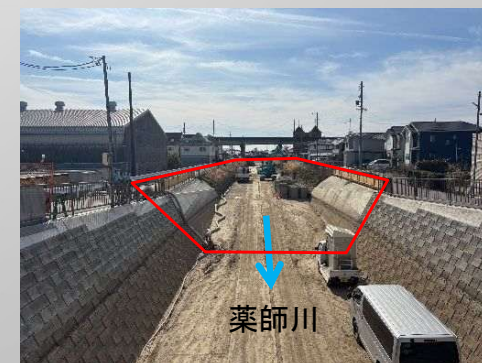
⑥薬師川：橋梁改築、河道整備
