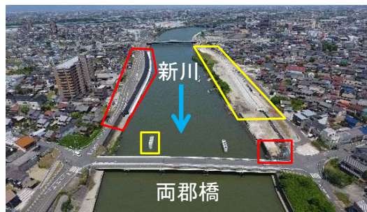
①新川：橋梁改築、築堤護岸工
