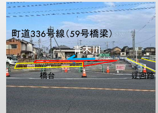
⑩青木川：橋梁改築
