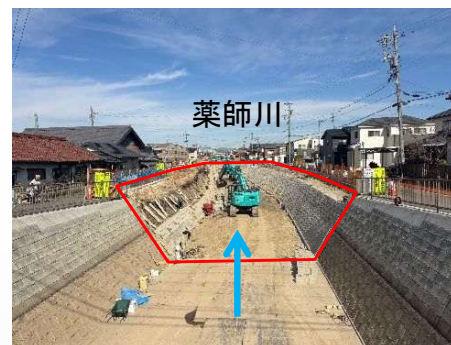
⑦薬師川：橋梁改築、河道整備
