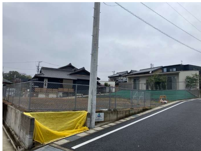
知々釜調整池
