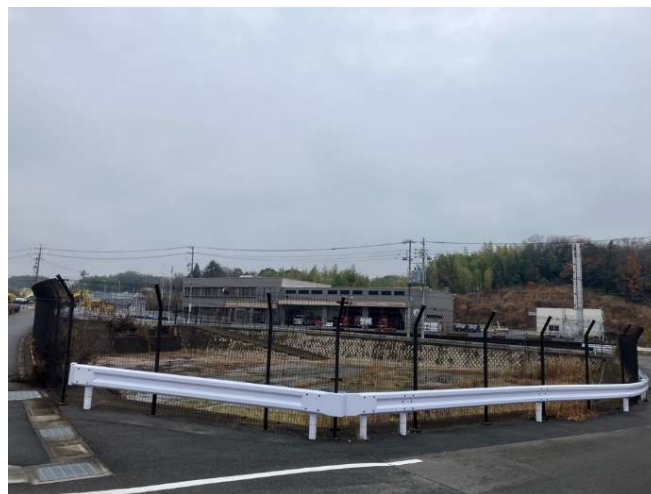
春木台調整池
