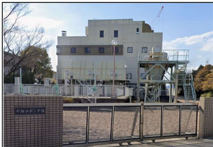
小垣江ポンプ場_外観
