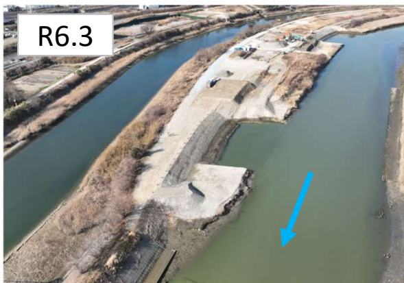
刈谷市三田町地内 河道拡幅
