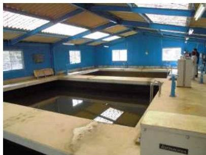
緩速ろ過池（豊根村 牧野浄水場）
