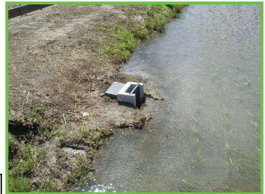
田んぼダム施工状況
