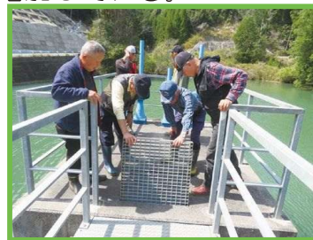
ため池の点検
