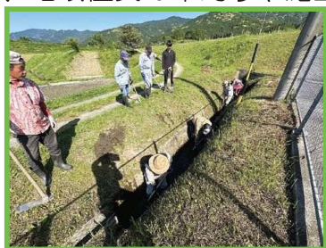
水路の泥上げ
