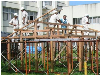
木造建築の建て方
