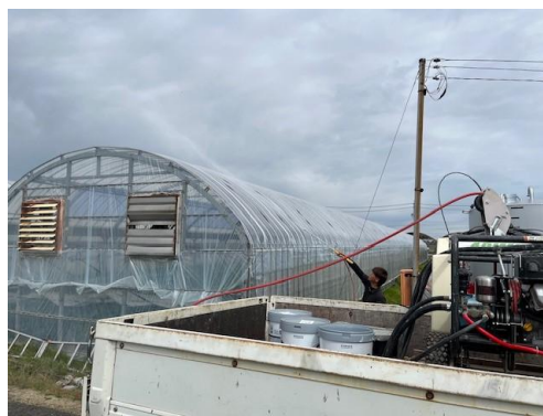
委託業者による遮光剤塗布の様子
