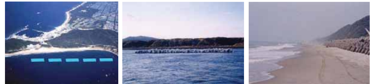
①人工リーフ（渥美海岸〔恋路ヶ浜〕）②離岸堤（赤羽根漁港海岸〔若見〕）③消波堤（田原海岸〔大草〕）
