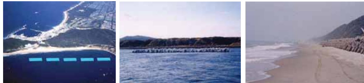
①人工リーフ（渥美海岸〔恋路ヶ浜〕）②離岸堤（赤羽根漁港海岸〔若見〕）③消波堤（田原海岸〔大草〕）
