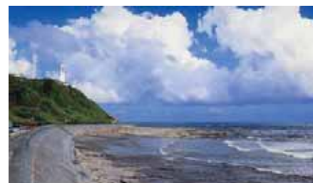
⑨堤防（御前崎海岸）
