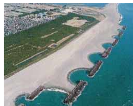
⑦離岸堤（浜松五島海岸）
