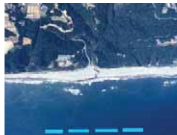
⑤潜堤（高豊漁港海岸〔伊古部〕）
