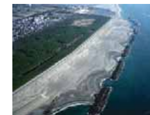
⑦離岸堤が設置されている浜松五島海岸
