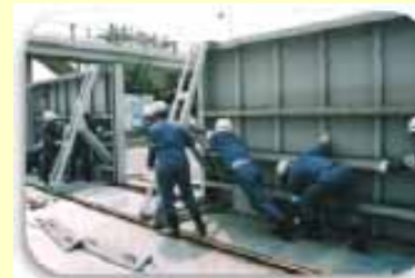
(陸閘の閉鎖作業)
