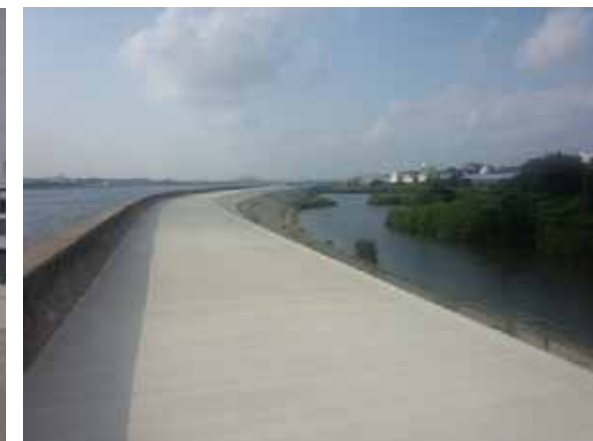
耐震対策実施後の海岸堤防 (高浜海岸)
