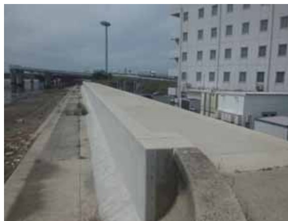
耐震対策実施後の海岸堤防 (三河港海岸)
