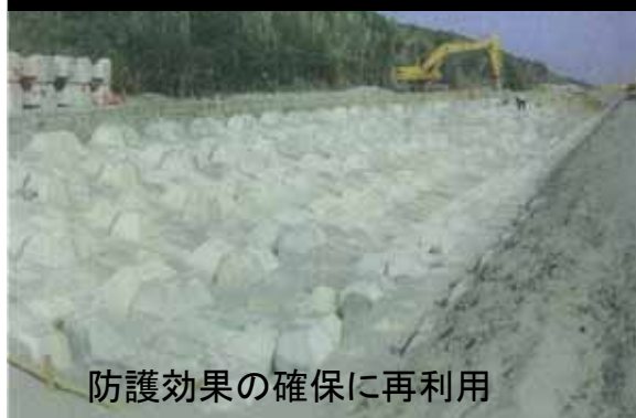
ブロックを移設し、緩傾斜護岸を整備
