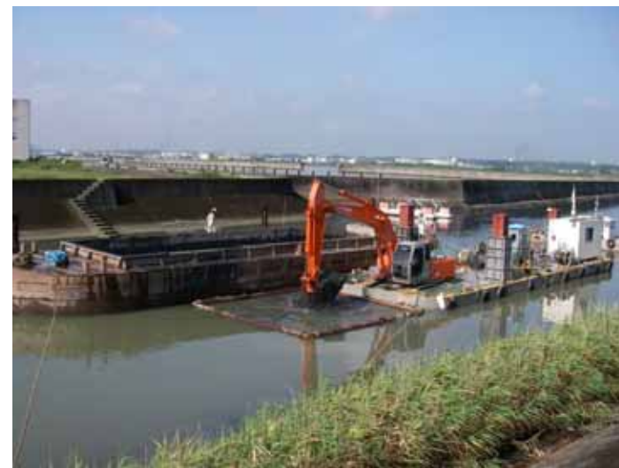
汚泥除去 施工状況(衣浦湾北部)
