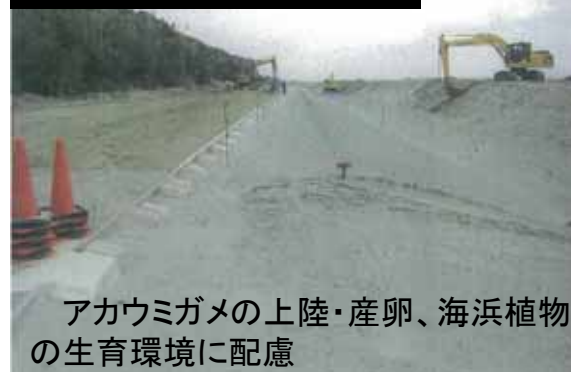
緩傾斜護岸を覆土
