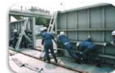
(陸閘の閉鎖作業)
