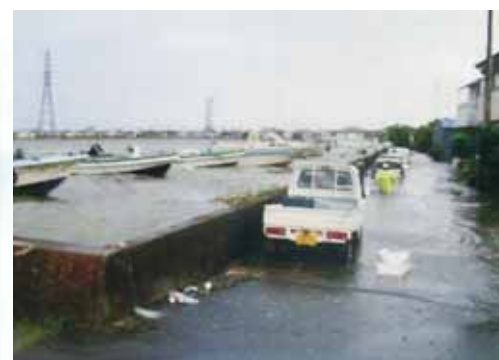
二級河川 柳生川(豊橋市)
