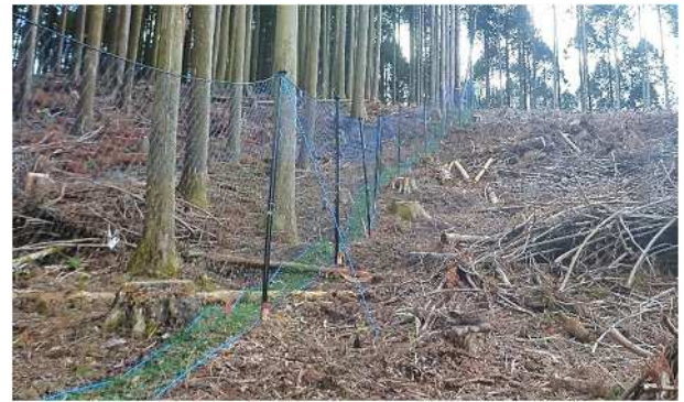
獣害防止柵設置（豊田市立岩町 地内） 柵は高さ 1.8m、下部 1m はステンレス入りネット
