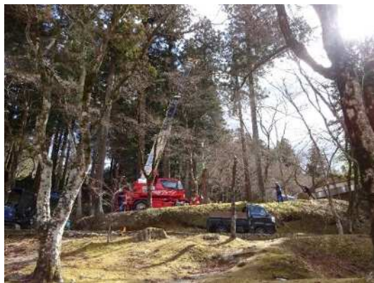
景観維持のための森林整備（豊田市）
