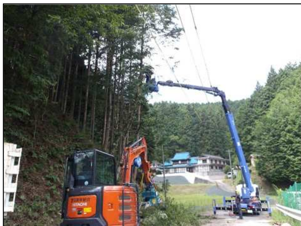
重機使用伐倒（豊田市）
