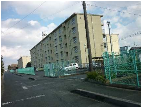
南西方より調査対象地
