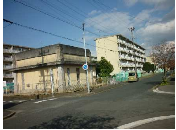
南東方より調査対象地
