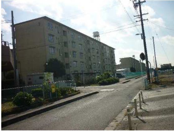
北西方より調査対象地
