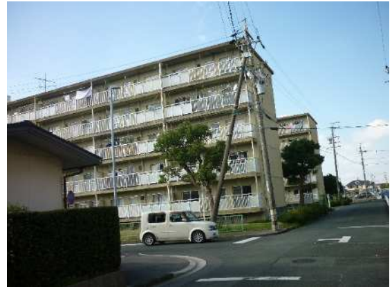
北東方より調査対象地
