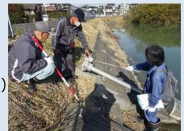
ため池の現地パトロール
