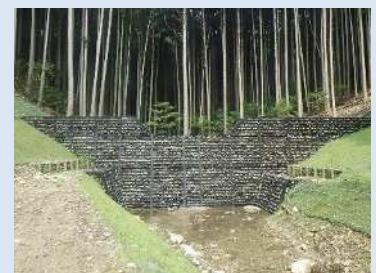
治山施設の整備
