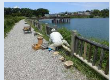
ため池木柵の補修状況
