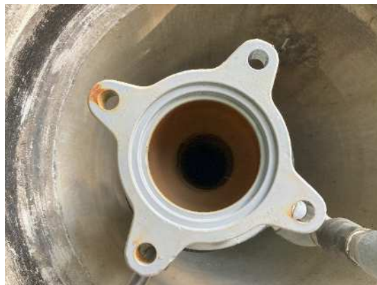
写真-14 弁箱内の状況
