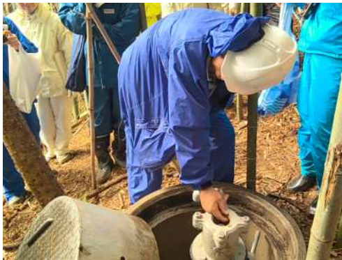
写真－8 現地調査（21号空気弁）
