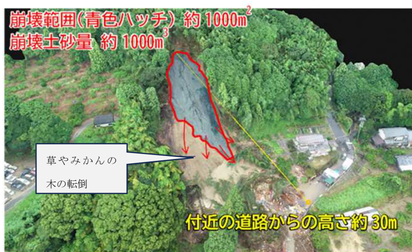
図－1 被災箇所斜め写真（中部地方整備局提供資料（8/28撮影）に加筆）
