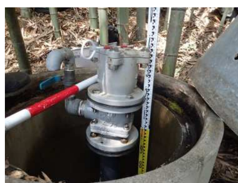
写真-5 空気弁等接続箇所からの漏水なし
