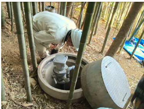
写真－10 現地調査（21号空気弁）
