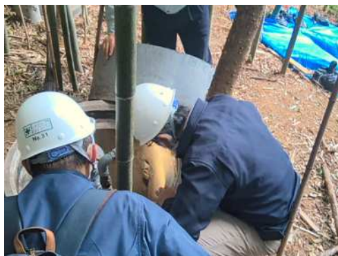
写真－12 現地調査（21号空気弁）
