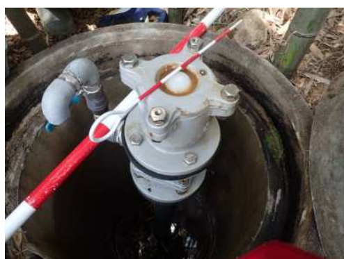
写真-4 立ち上がり管からの漏水なし
