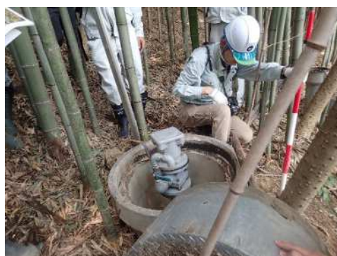
写真-7 現地調査（21 号空気弁）
