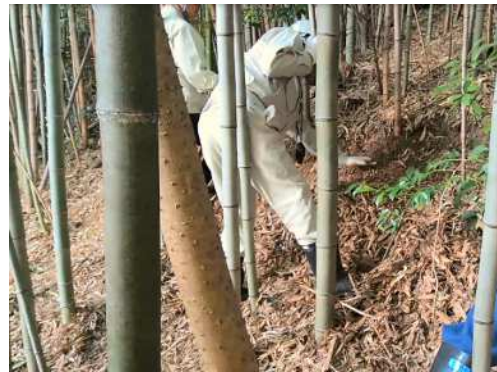
写真－11 現地調査（蒲郡支線斜面上側）
