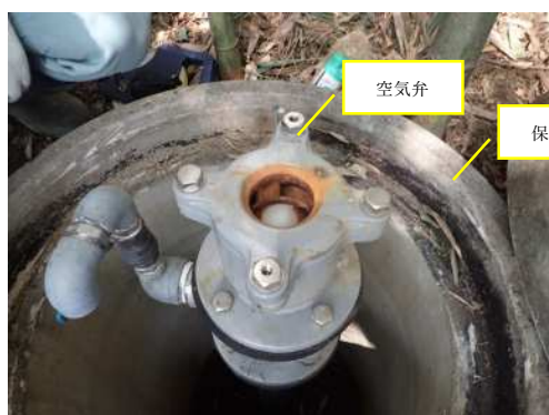
写真-2 空気弁に水が到達する前の状況
