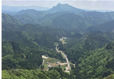
国道 473 号 設楽バイパス
