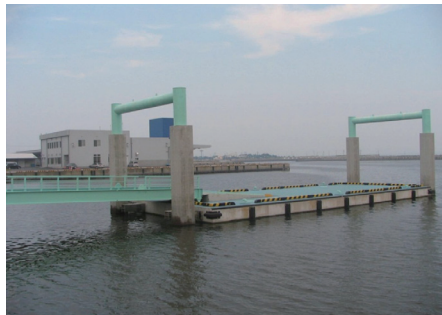
一色漁港の浮棧橋
