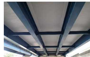
床版断面補修完成
