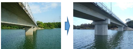
整備前 整備後 橋梁の耐震補強
