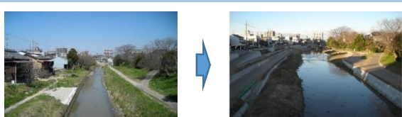
整備前 整備後 河川改修による洪水対策
