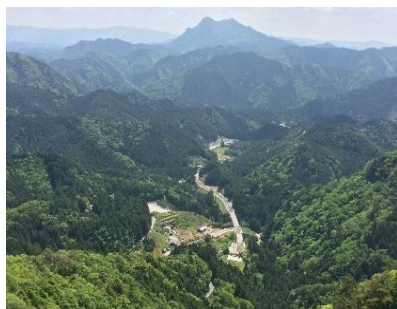
国道473号 設楽バイパス
