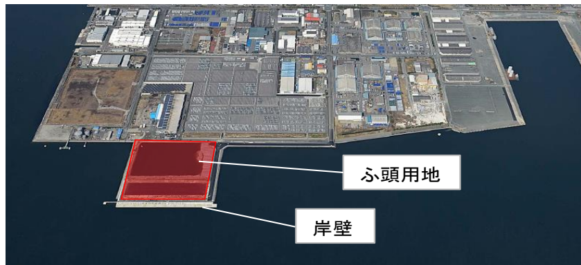
三河港(蒲郡地区)岸壁・ふ頭用地整備
