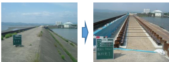
整備前 鋼矢板＋タイロッド施工後 海岸堤防の耐震化
