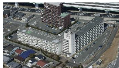
県営住宅の長寿命化改善工事改修前
