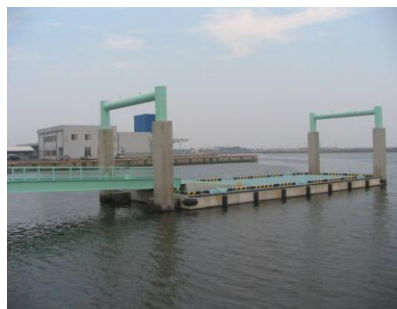
一色漁港の浮棧橋
