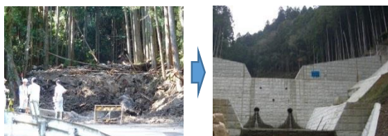
整備前 整備後 土砂災害危険箇所の施設整備
