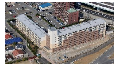
県営住宅の長寿命化改善工事改修後
