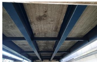
床版断面補修着手前
