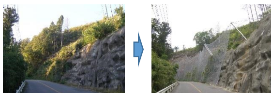
整備前 整備後 落石等防止対策
