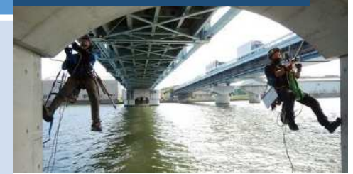
(国)247号 衣浦大橋(半田市)
