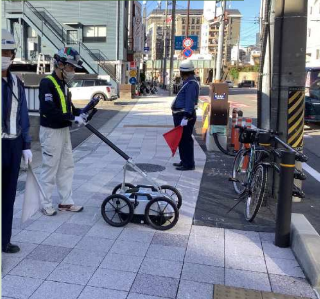
地中レーダー探査の様子
