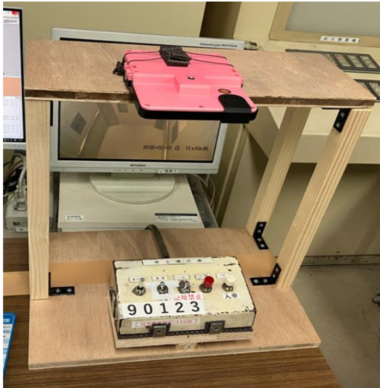
まちか（公共第1）駐車場
