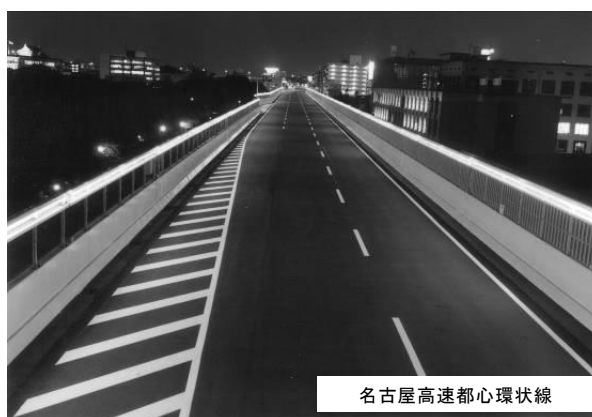
図 3.46 ヒメボタルへの影響に配慮した高欄照明
