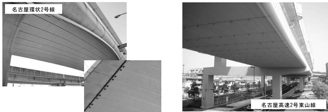
図 3.15 高架裏面吸音板設置例
