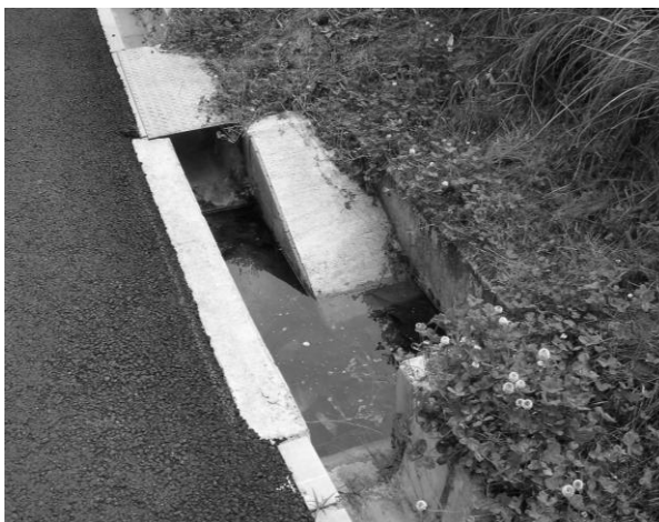
図 3.43 小動物が脱出できる側溝の例
