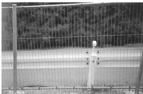
写真-1 縦目型フェンスの設置
