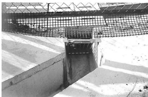
写真-2 フェンス下部からの侵入防止
