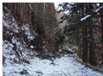
県道古真立津具線（設楽町津具地内）
