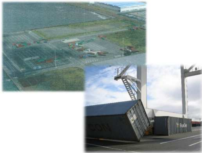
横転するコンテナ（神野地区）
