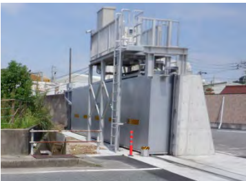
陸閘の改築（衣浦港海岸：愛知県高浜市）
