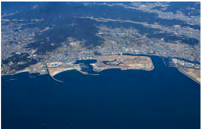
覆砂箇所（三河港：愛知県蒲郡市）
