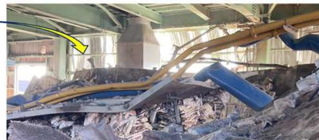
ガス配管(黄色)は窯の上部を通っていたことから、爆発により窯の上方へ飛び、建物の梁に沿って凹んでいる
