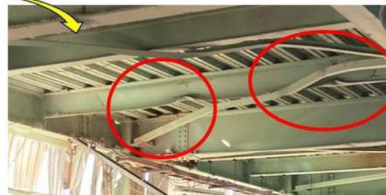
爆発により窯の上部が上方へ飛び、建物の梁に接触したことによる凹み(消防談)
