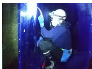
管きょの修繕(老朽化対策)
