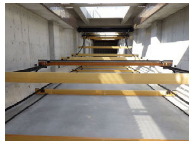
処理場 増設工事(水処理施設)
