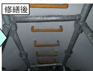
マンホールの修繕(老朽化対策)
