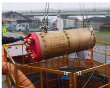
管きょ工事(掘進機)
