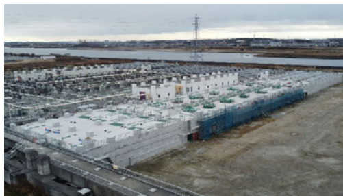
処理場 増設工事(水処理施設)
