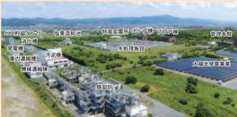
水処理施設と汚泥処理施設
