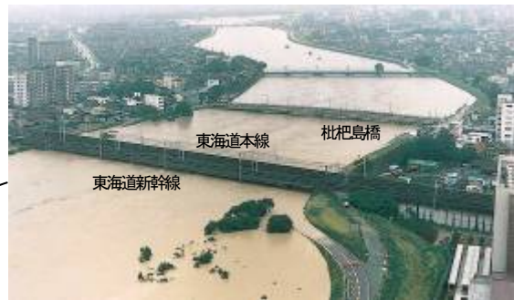
JR東海道新幹線庄内川橋りょう付近 【平成12年東海豪雨時】(名古屋市西区・清須市)
