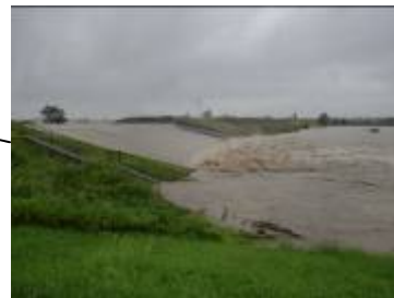
激待事業後初めて越水する洗堰 (名古屋市北区) 【平成23年9月台風15号時】
