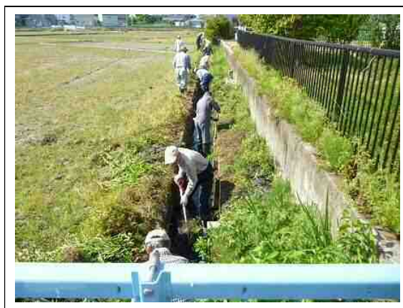
農業用排水路の泥上げ
