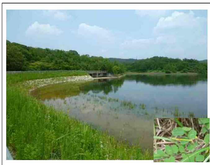
水環境整備事業岩藤新池1期地区
