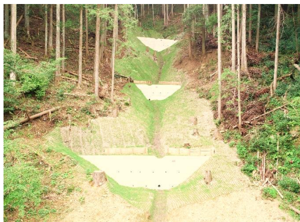
土留工（東栄町）
