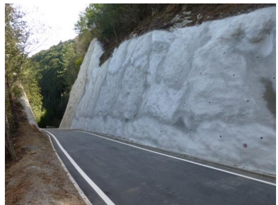
林道改良事業（改良） 塩瀬本線（新城市）
