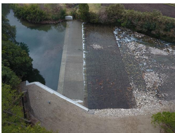
取水堰の整備（新城市布里地区）
