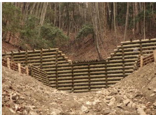
木製校倉式治山ダム（豊根村）
