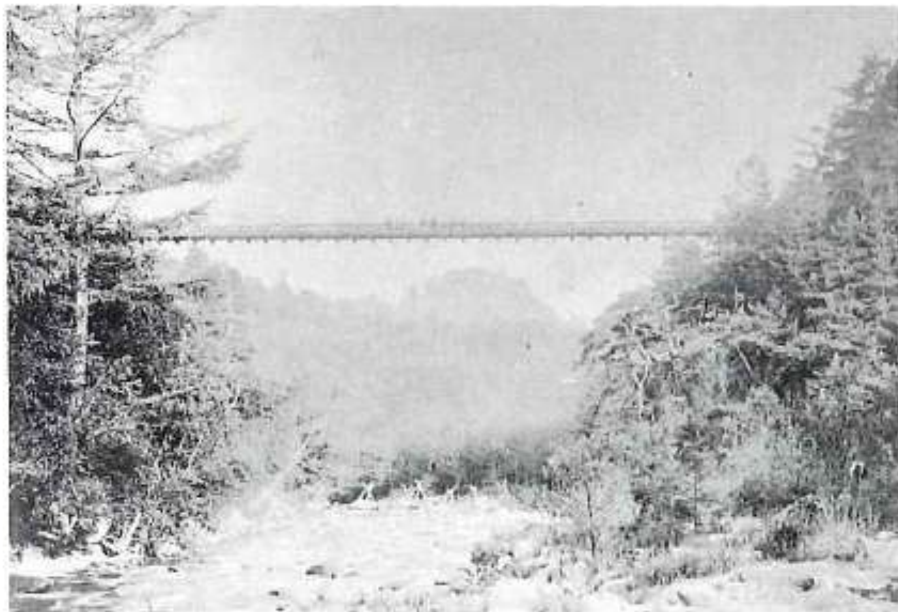
金峰橋 この吊橋を渡る軌道によって梓久保地帯500余町歩の山林から木材がトロッコで御所平まで運ばれた
