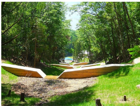
治山事業（豊田市足助白山町）
