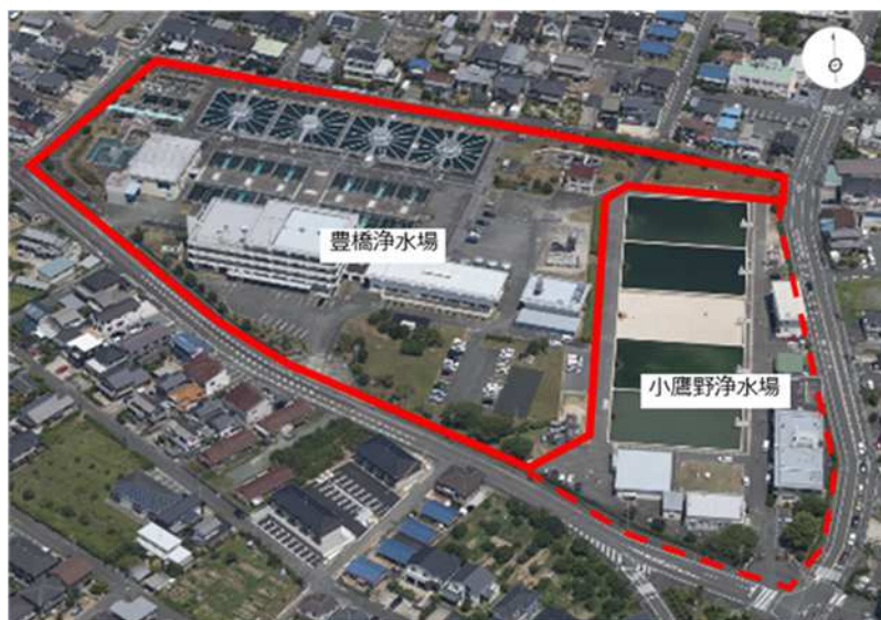
図表1 豊橋浄水場全景
