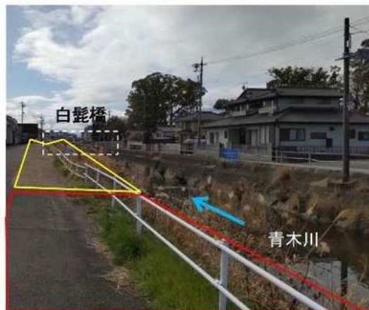
⑤青木川：河道整備
