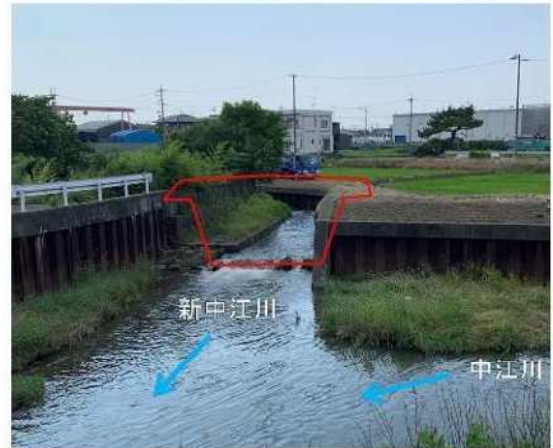
⑦新中江川：河道整備
