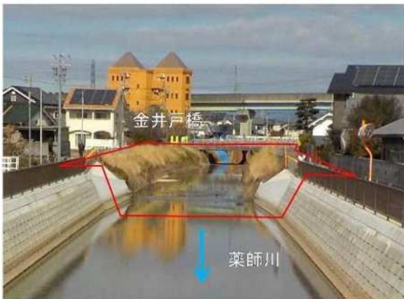
⑧薬師川：橋梁改築、河道整備
