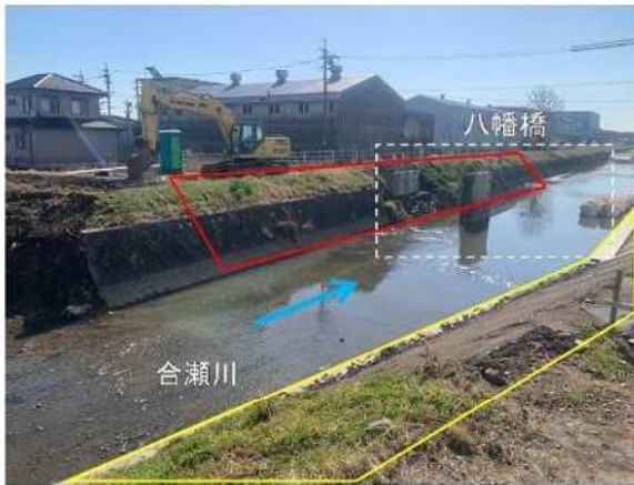
⑥合瀬川：橋梁改築、河道整備
