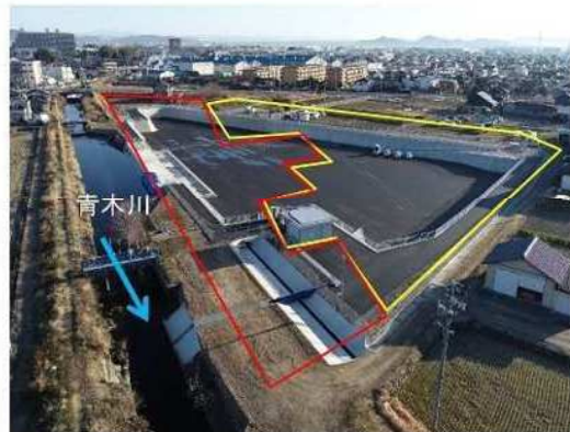
⑫青木川（第4調節池）：調節池整備
