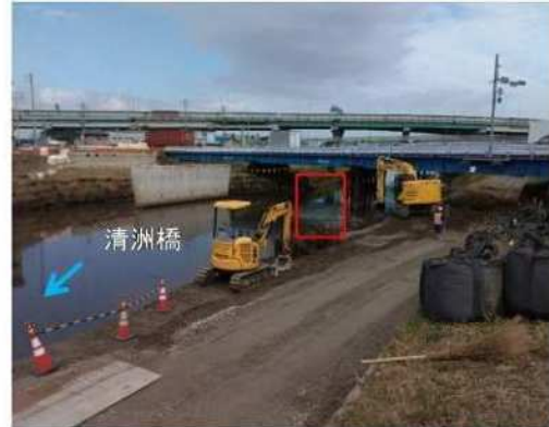
②五条川：橋梁改築、河道整備
