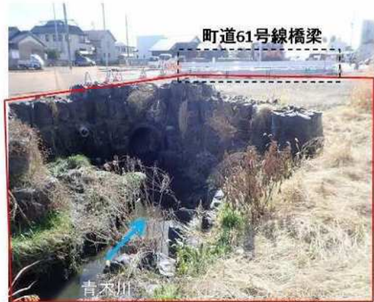
④青木川：河道整備
