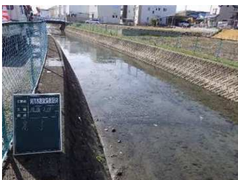
準用河川般若川改修（江南市）（完了後）
