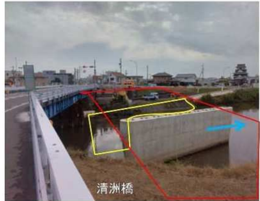
②五条川：橋梁改築、河道整備
