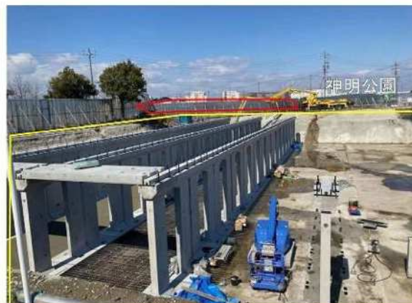
⑩大山川調節池：導水路整備
