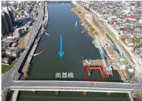
①新川：橋梁改築、築堤護岸工
