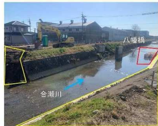
⑥合瀬川：橋梁改築、河道整備
