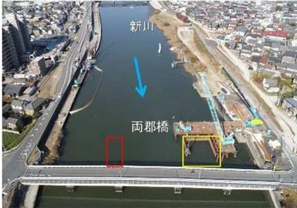
①新川：橋梁改築、築堤護岸工
