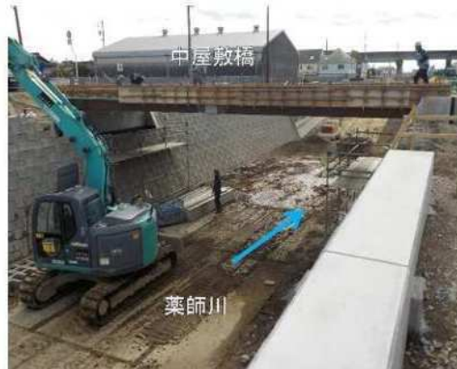
⑧薬師川：橋梁改築、河道整備
