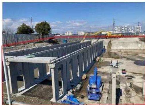
⑪大山川調節池：導水路整備
