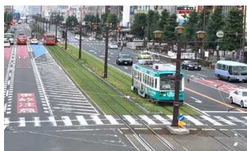
軌道敷緑化（豊橋市）
