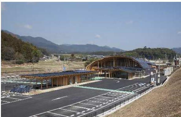
大型の木造公共施設（新城市）
