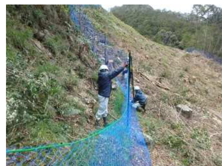
獣害防止柵の設置
