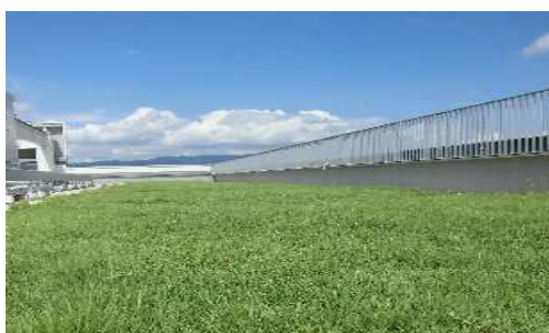
公共施設の屋上緑化（愛西市）
