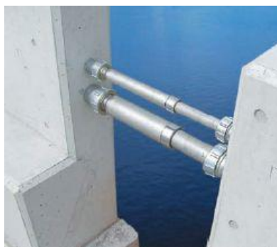
写真 7.1.1 地覆等における配管接続部の事例
