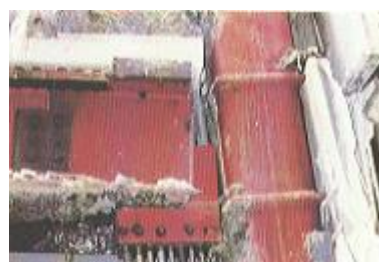
端部が破断した鉄骨ばり (参考・引用文献⑩)
