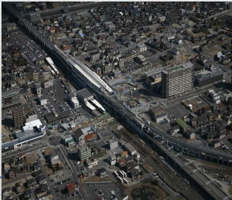
東海太田川 連続立体交差事業
