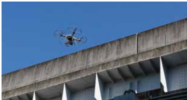
ドローンをを用いた橋梁点検(実証実験の様子)
