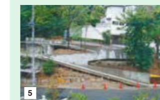
つづら折れ状のRC基礎が完成した状態。
