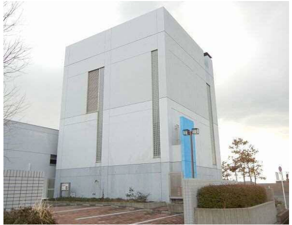
図IV-1-6 エネルギー棟
