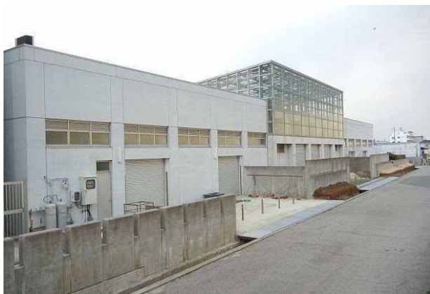
図IV-1-5 エコシステム実験棟
